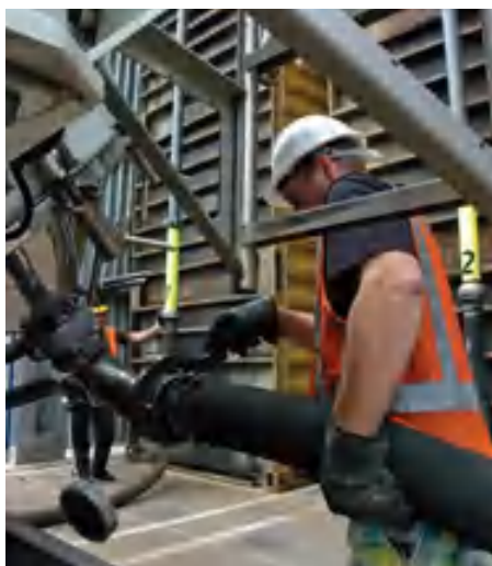
Afb. 3 De vulslang van de bulkwagen wordt aan de stijgleiding van het vulstation gekoppeld
