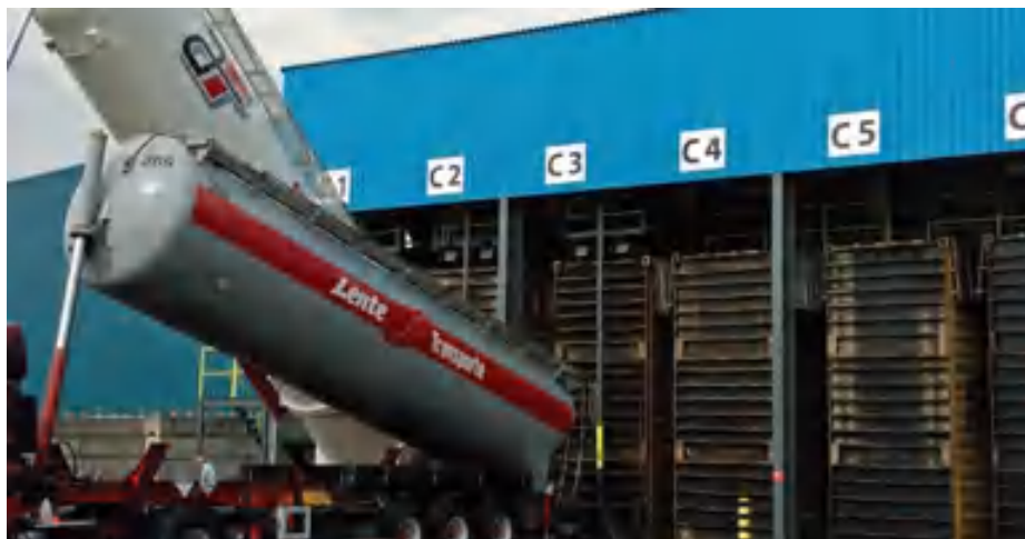
Afb. 1 Het overslagsysteem voor zinkhoudend staalstof maakt gebruik van verticaal opgestelde zeecontainers die vanuit bulkwagens worden beladen
